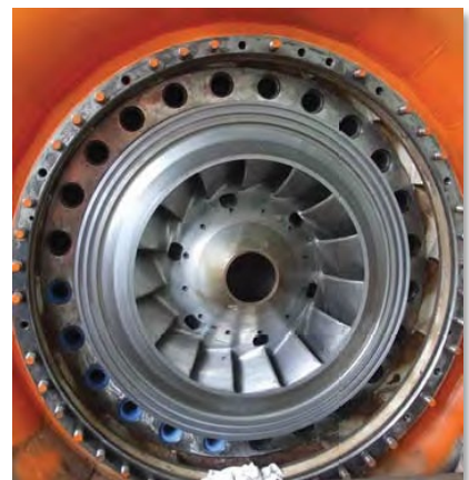
Подшипники ThorPlas, установленные на турбине Francis на электростанции Tuai, Новая Зеландия
